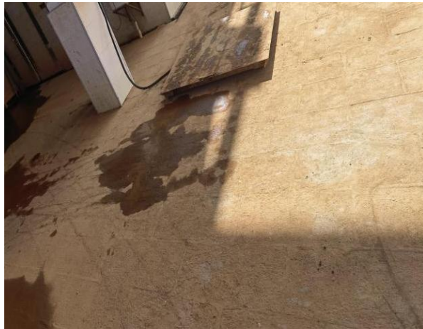
地下事故应急池
